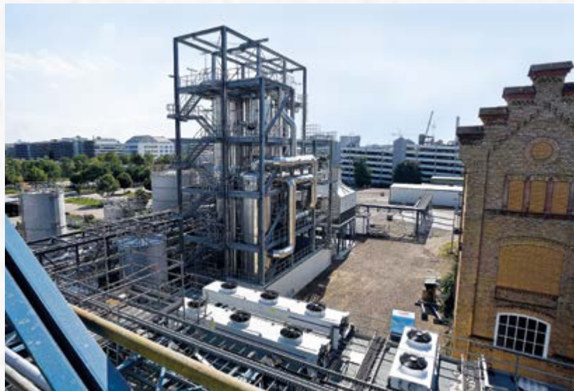
Neues neben Altem: Die Mannheimer Strohzellstoff-Fabrik erforderte umfangreiche Neubauten, teils direkt neben den alten Gebäuden. Links im Bild die Eindampfanlage für das weiterverwendbare Nebenprodukt Lignin. Die Anlage ist 30 Meter lang, 16 Meter breit und 34 Meter hoch.
